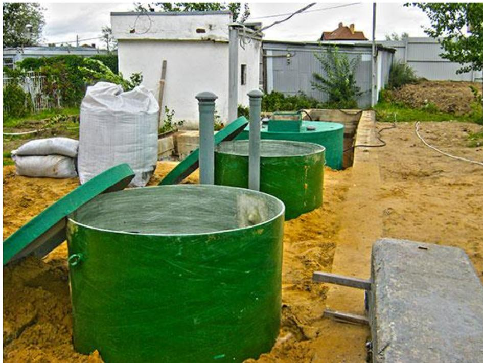
Ливневая установленная канализация работает следующим образом. В ее основе отходные материалы оседают сначала в пескоуловителях (ЛОС-П), затем отходы нефтепродуктов собираются в нефтеуловителях (ЛОС-Н). После этого объемы воды проходят сорбционный фильтр ливневой канализации (ЛОС-Ф).
