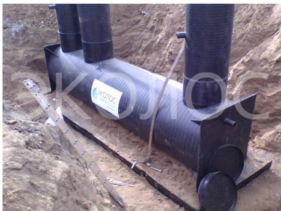
Монтаж станции биологической очистки, производительностью 100 м<sup>3</sup>/сут
